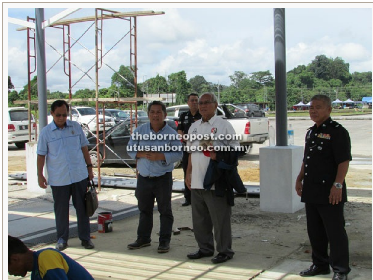
PANTAU: Jabu sebelum mempengerusikan Mesyuarat Persiapan Pembukaan Rasmi RTC Betong sempat melawat kawasan sekitar bangunan yang sedang giat disiapkan.
